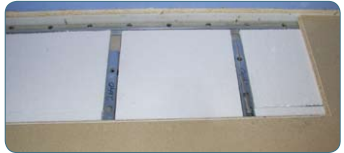
Golv i princip färdigt för mattläggning. Cellplast används som isolering.
